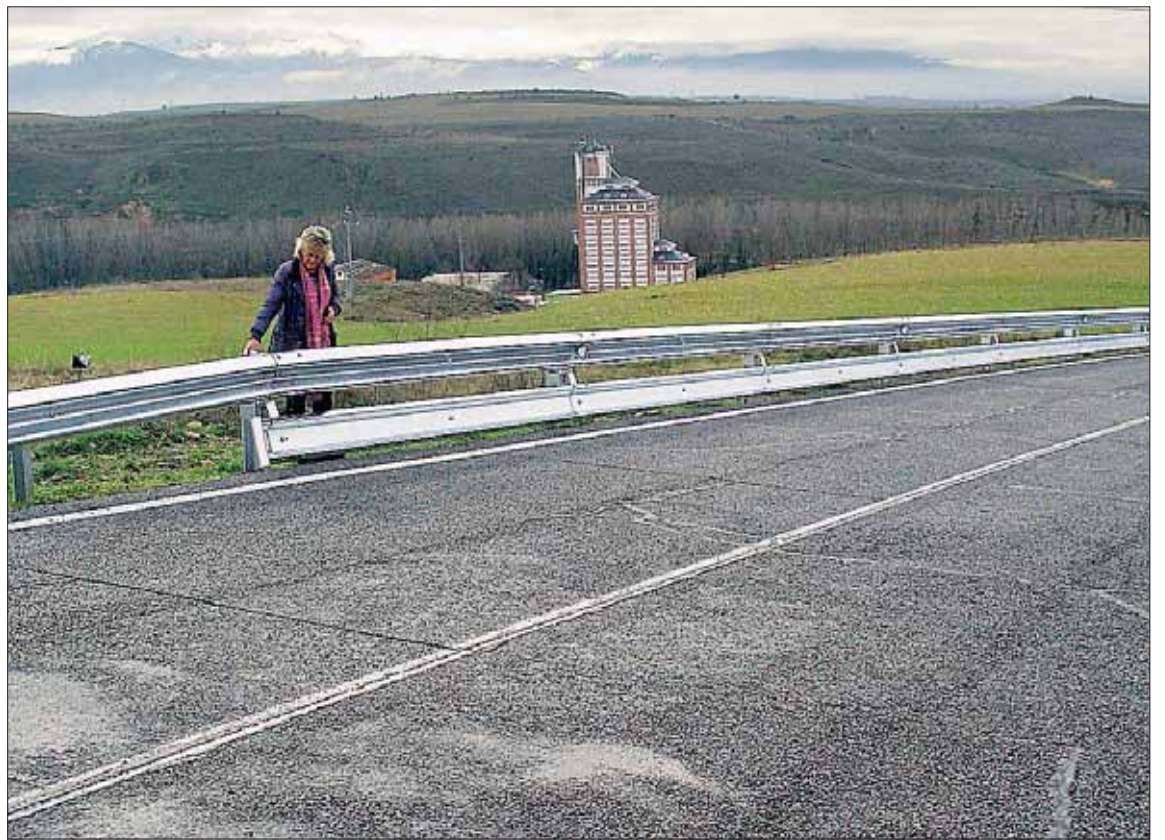
La concejala Paloma Maroto, inspeccionando la actuación llevada a cabo en la carretera del Peñigoso. / EL ADELANTADO
