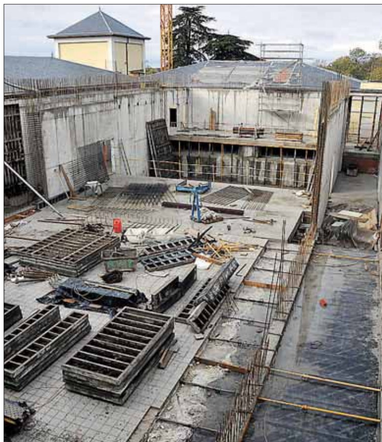
El Palacio de Congresos "La Faisanera", en obras. / JUAN MARTÍN
