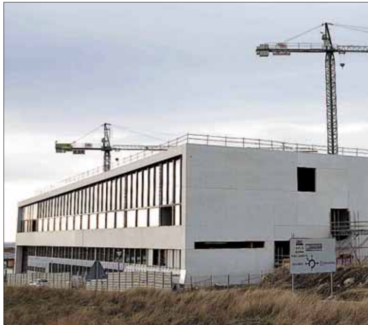
El pasado mes de octubre se reanudaron las obras del primer edificio. // J. MARTÍN
