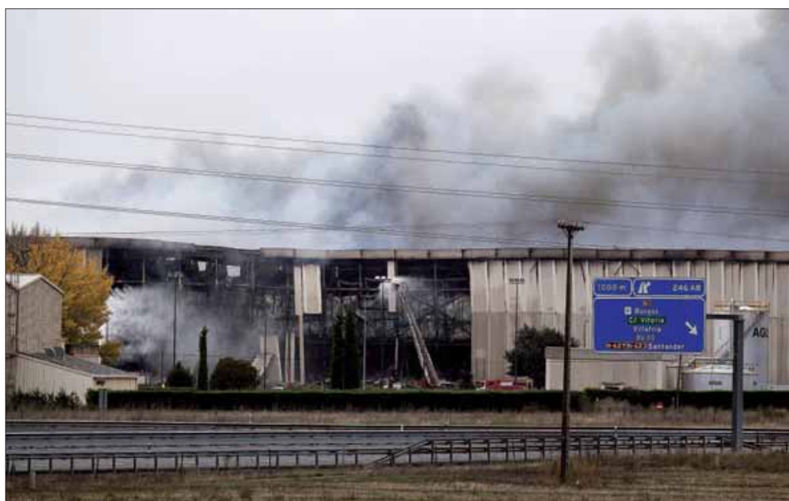
El incendio ha provocado el derrumbe de varias paredes de la fábrica de Campofrío en Burgos. / SANTI OTERO/EFE
