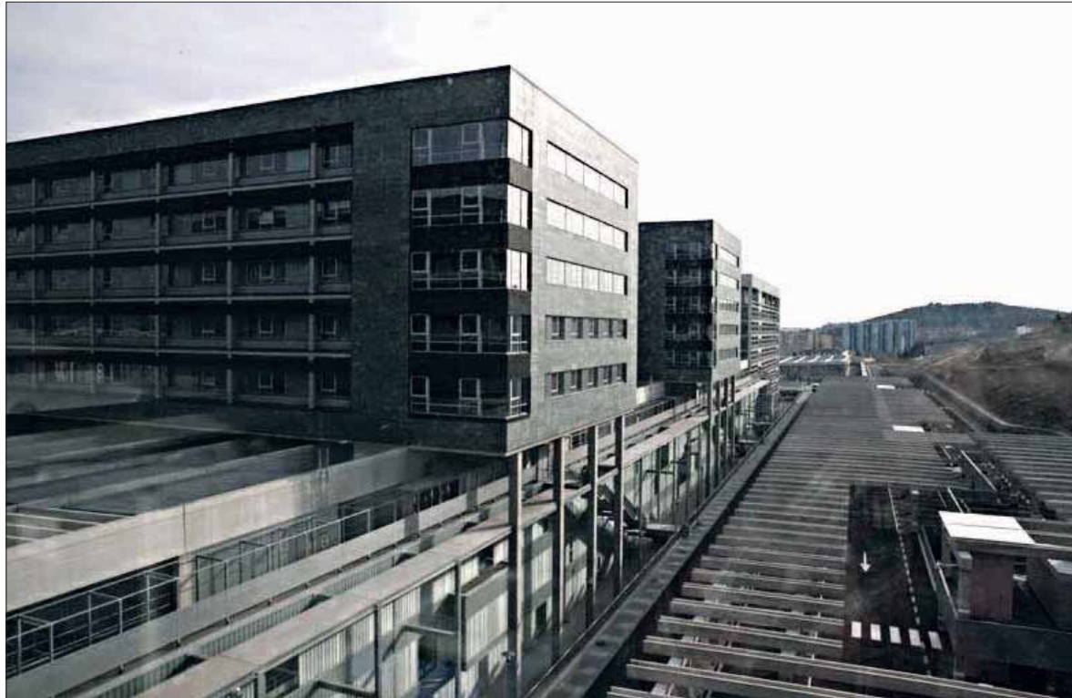
Vista panorámica de las instalaciones sanitarias del hospital Universitario de Burgos. / EUROPA PRESS
