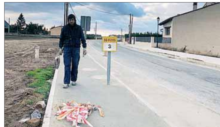
Estado actual de la carretera. / LOURDES MATARRANZ
