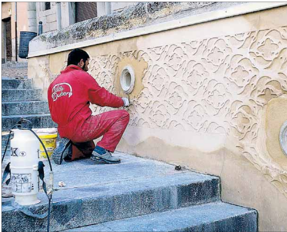
Aprovechando el espacio que ocupaban las luminarias, se han instalado seis gárgolas con forma de boca de cañon. / A.S.
