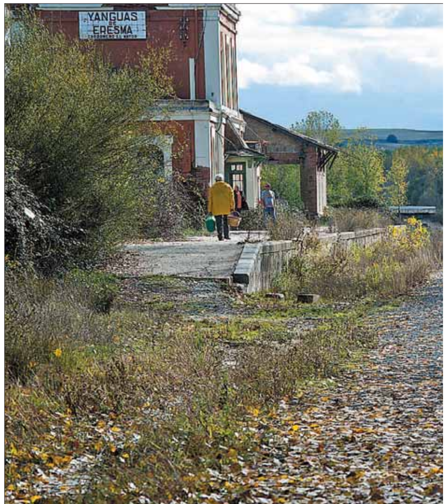
La plataforma del segundo tramo de la vía verde ya está preparada desde Yanguas de Eresma pa
