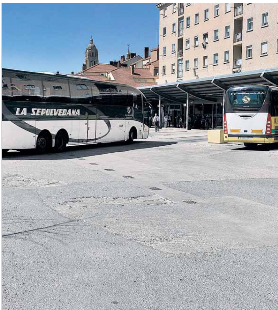
La reforma de la terminal de autobuses será costeada por el Ayuntamiento y la Junta al 50%. / KAMARERO
