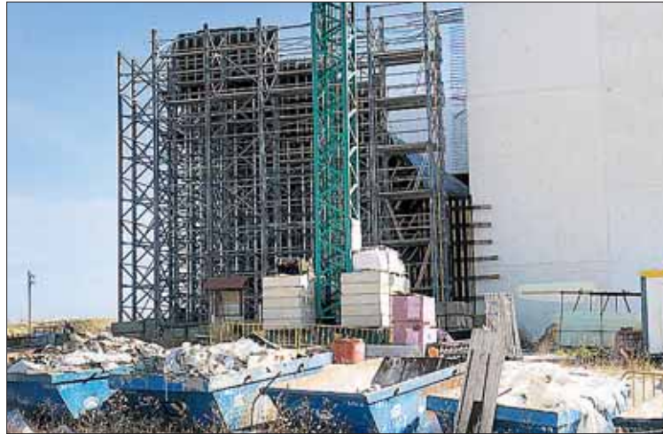
Las obras de terminación exterior del edificio costarán 1,8 millones. / KAMARERO
