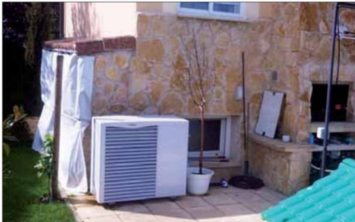
de calor compacta aire-agua de Vaillant.
