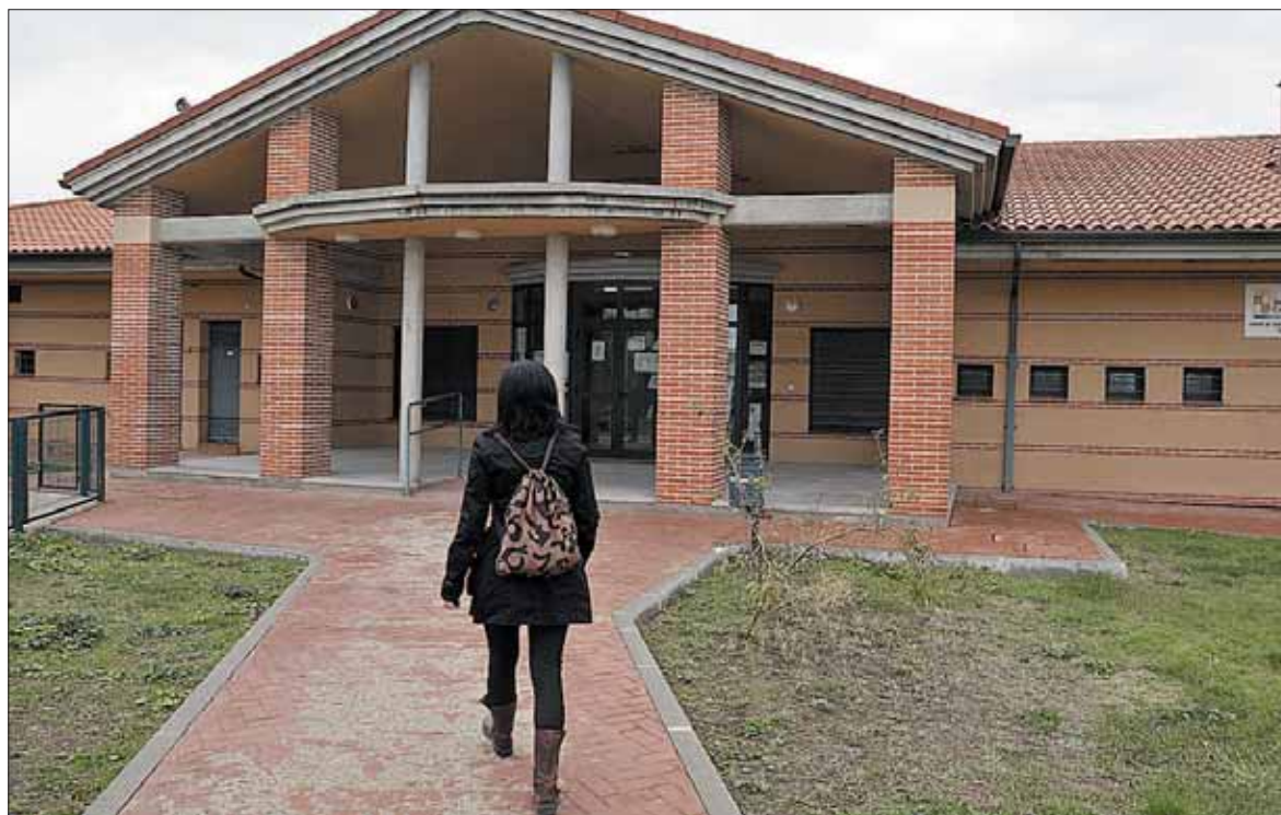
Entrada al colegio 'Las Cañadas' de Trescasas, que se abrió en enero de 2010. / JUAN MARTÍN
