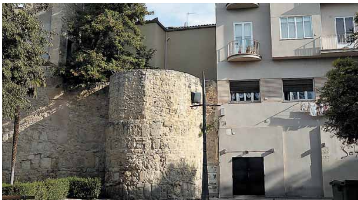
La trasera del edificio emerge por detrás del castillete. La frondosidad de un árbol oculta la estructura. / JUAN MARTÍN
