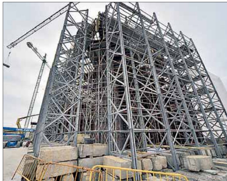
La obra permanece paralizada desde junio de 2013. / KAMARERO
