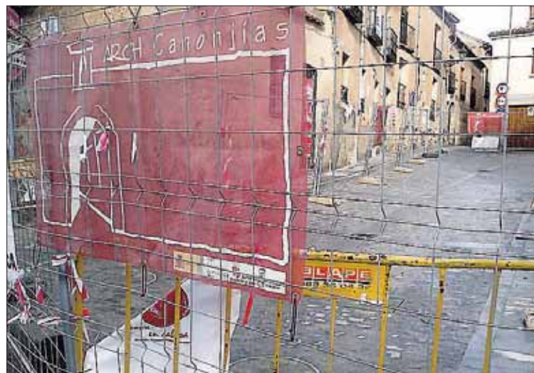
Vallas de las obras de la plaza de Juan Guas. / EL ADELANTADO
