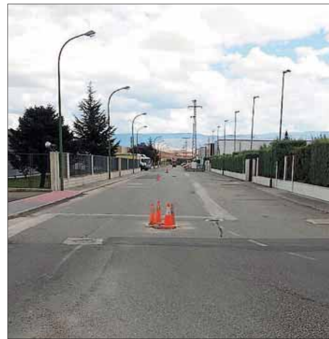
La señalización indica el inminente inicio de las obras. / EL ADELANTADO
