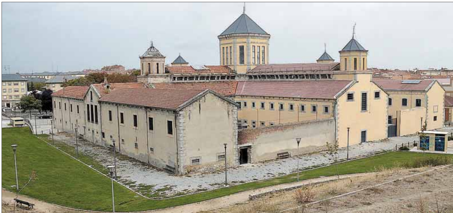
Parte de los desempleados que ahora serán contratados trabajarán en nuevas obras de remodelación de la antigua cárcel de Segovia. / JUAN MARTÍN
