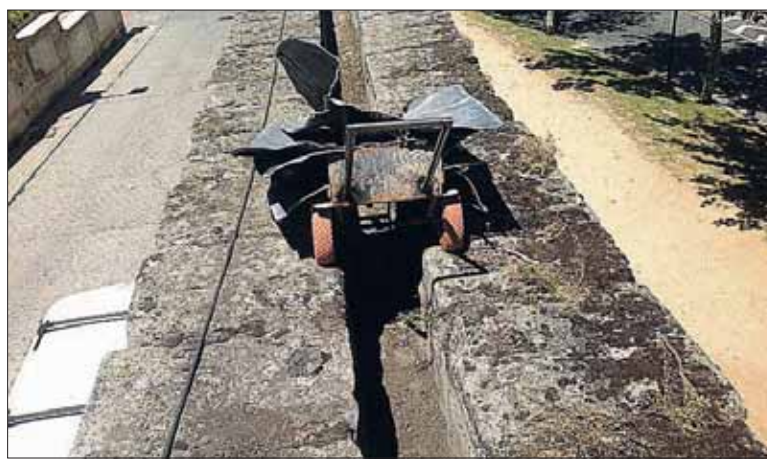
El canal de plomo fue retirado tras cortarlo en piezas de un metro. / J.MARTÍN
