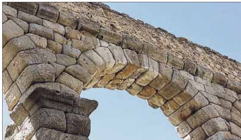
Las manchas de salitre, evidencias del problema de conservación por filtración. / B.C.P.
