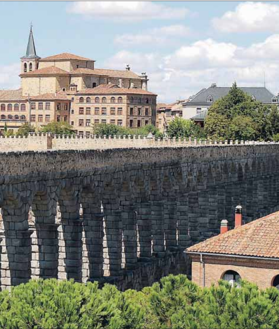
o e impermeabilización con cal hidráulica que ataja las filtraciones. / FRAN MUÑOZ
