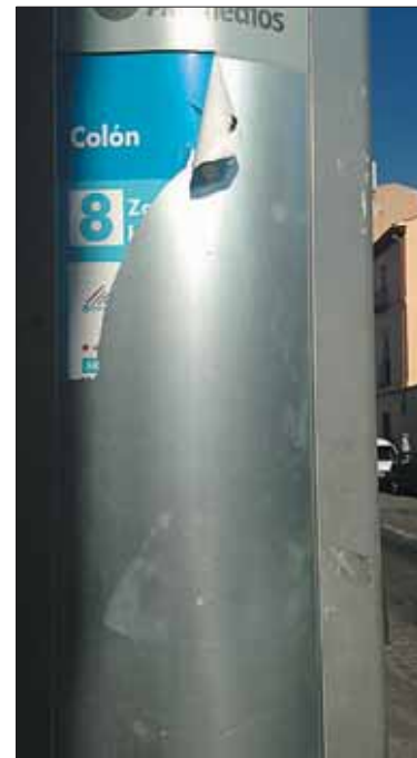
Poste de la calle Colón.
