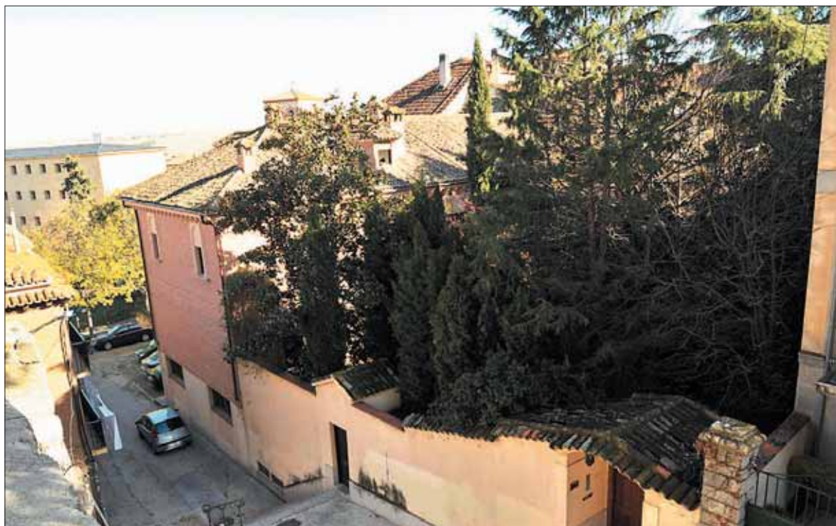
Casa del número 4 de la calle de la Parra, construida con una licencia que posteriormente fue declarada ilegal. / KAMARERO
