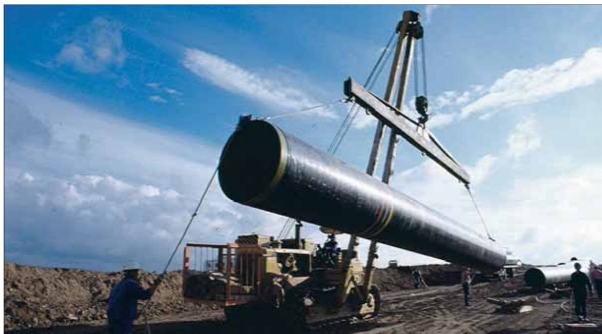
Operarios de Gas Natural Fenosa trabajan en la canalización de un gaseoducto. / AGENCIAS
