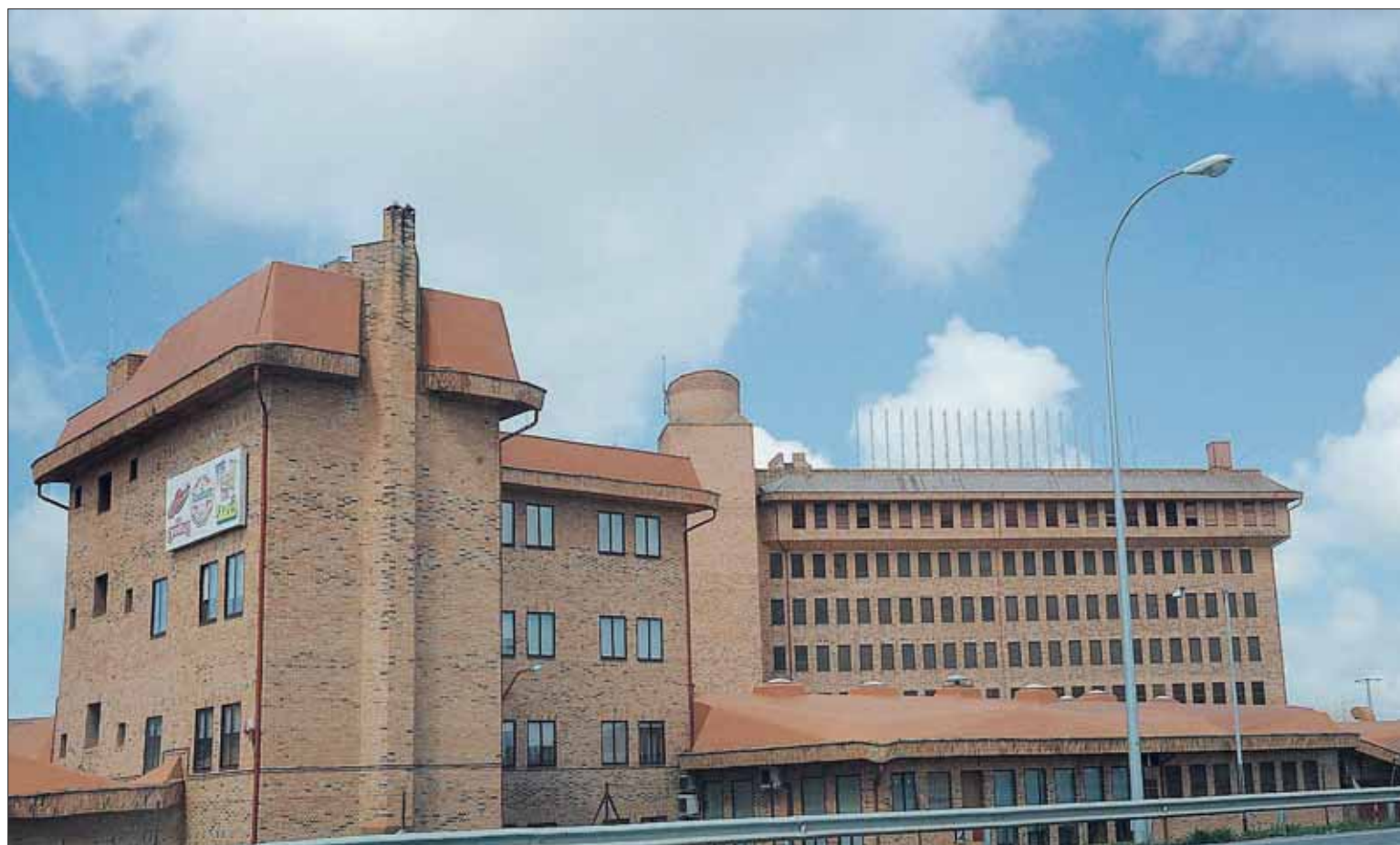
El edificio volverá en breve a recuperar la actividad industrial, en esta ocasión vinculado al sector del transporte. / KAMARERO
