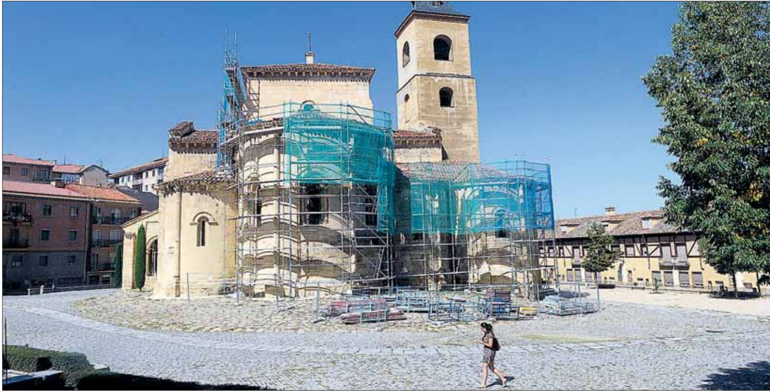
Los andamios comenzaron esta semana a cubrir las zonas en las que se intervendrá en el templo. / KAMARERO
