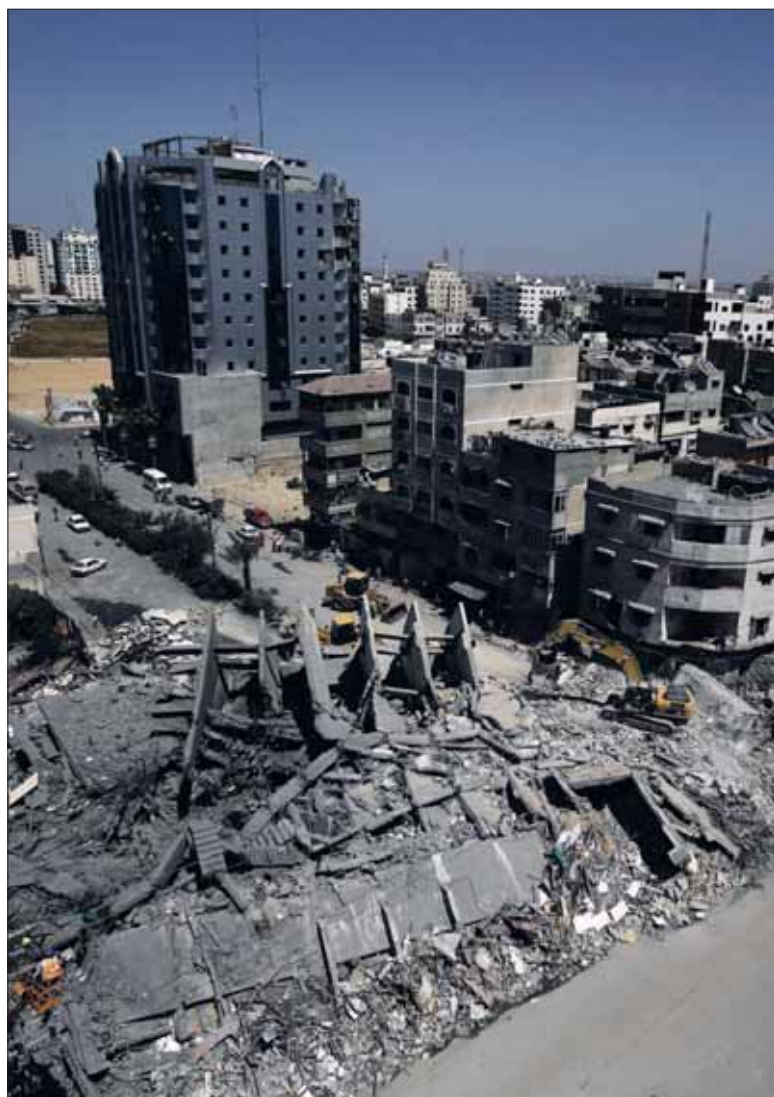
Vista de los restos de la torre Al-Basha destruida en Gaza ayer. / EFE
