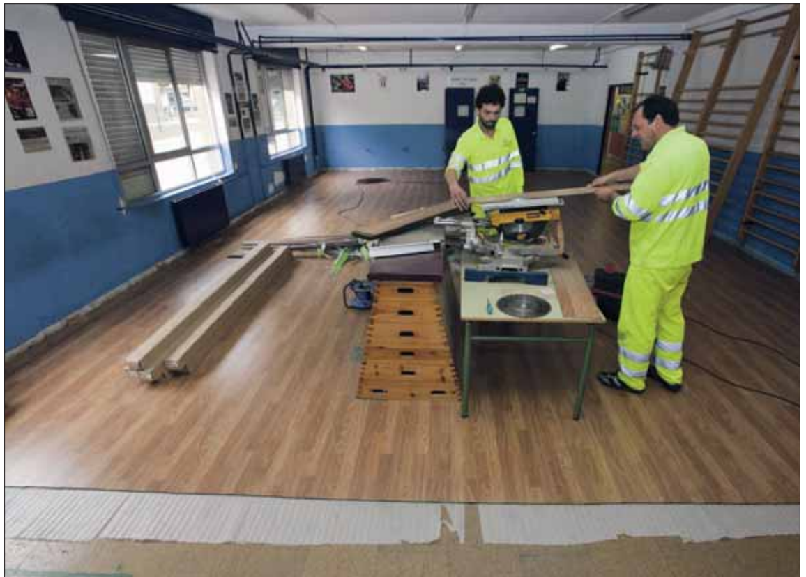
Varios operarios trabajan en la colocación de un parqué nuevo en un gimnasio de un centro educativo. /EUROPA PRESS
