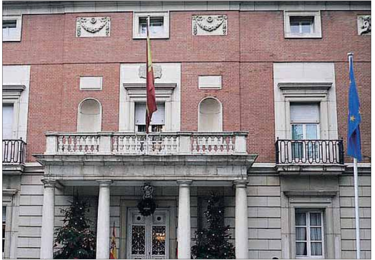
Fachada del Palacio de la Moncloa, sede de la Presidencia del Gobierno, ubicado en la zona noroeste de Madrid. / EP.
