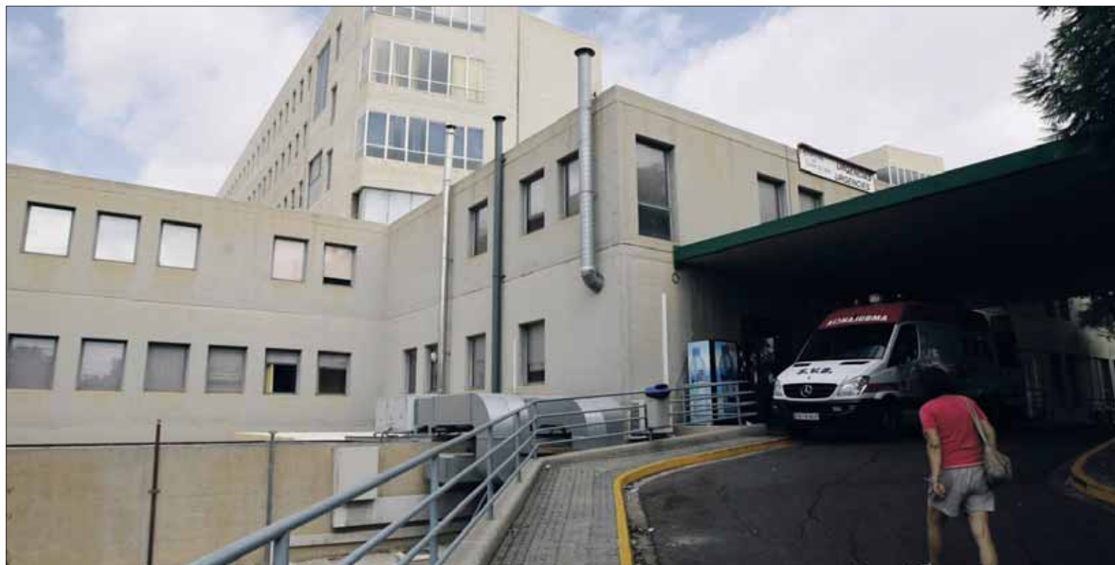
Rampa de acceso al departamento de Urgencias del Hospital Sant Joan de Alicante. / EFE
