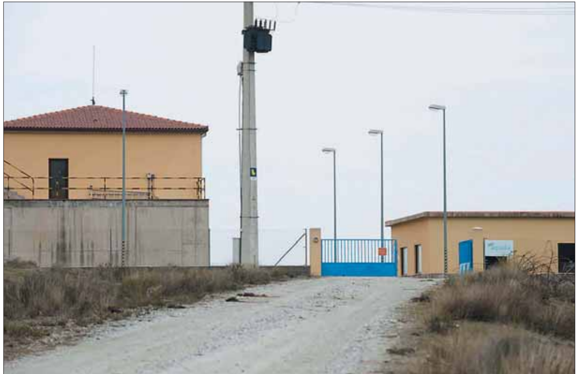
Acceso a la planta potabilizadora del Rancho del Feo, que comparten Segovia y Palazuelos. / EL ADELANTADO
