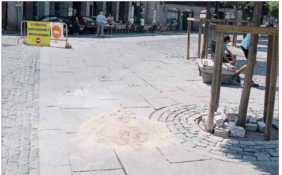
El pavimento de la Plaza Mayor presentaba ayer este aspecto, después del inicio de las obras. / FRAN MUÑOZ
