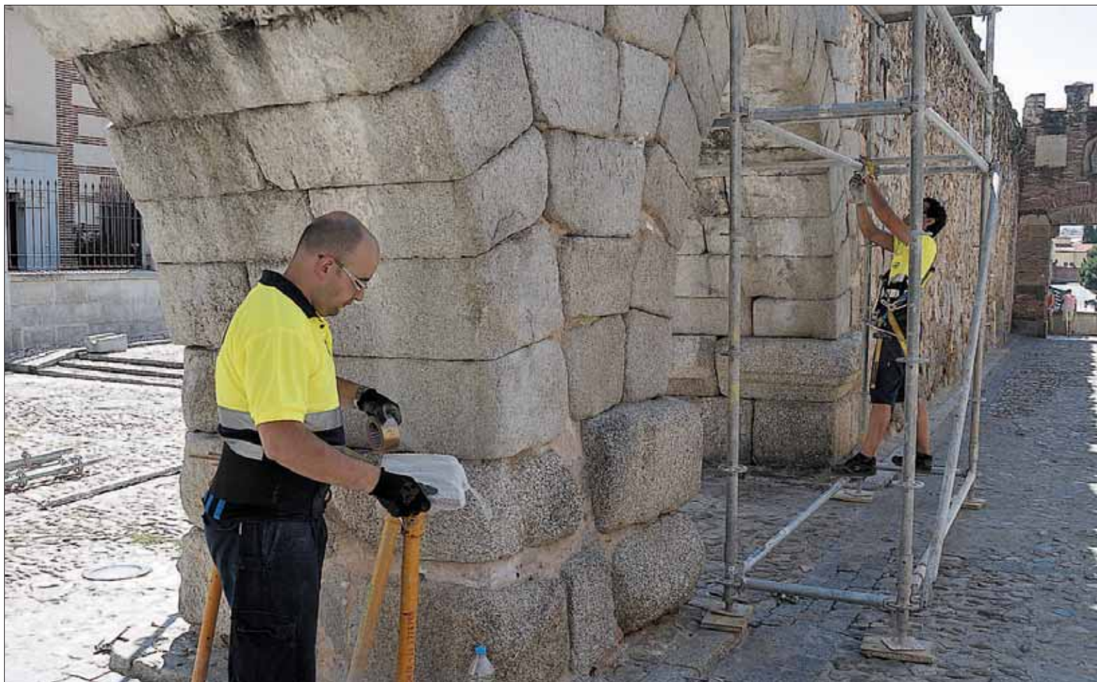
Dos operarios, colocando un andamio en las inmediaciones del Postigo, en la Plaza de Avendaño, una de zonas más afectadas por las filtraciones. / JUAN MARTÍN
