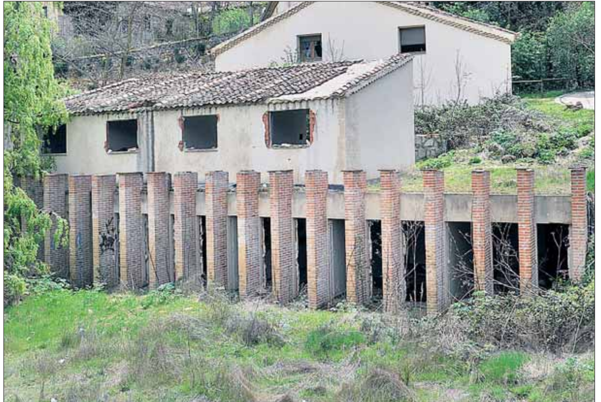
Imagen de archivo de los muros de contención que escondían habitaciones bajo tierra. / KAMARERO
