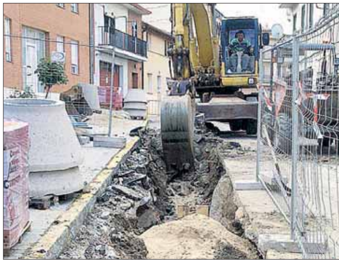
Uno de los operarios durante la realización de las obras. / EL ADELANTADO
