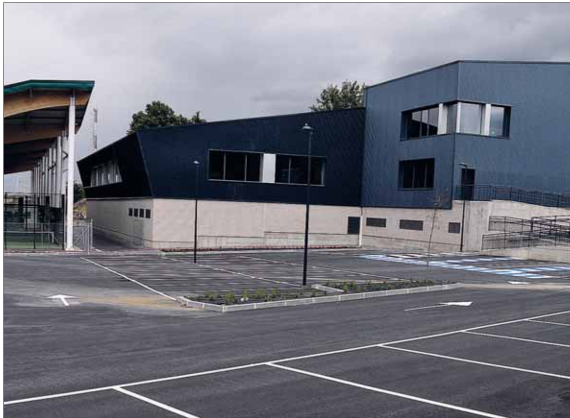
El edificio del complejo, situado en la ciudad deportiva de La Albuera, está casi construido. / JUAN MARTIN
