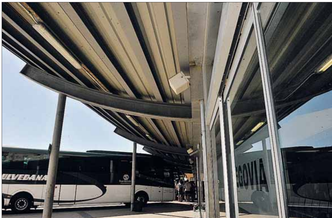
Una de las obras será la de desmontar la marquesina anclada al edificio, en cumplimiento de sentencias judiciales. / K.
