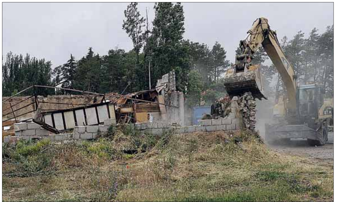
Una retroexcavadora de la empresa segoviana La Paloma S.A. ha derribado los muros del viejo edificio. / JUAN MARTÍN
