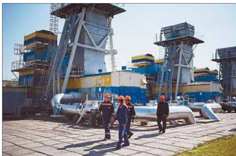
Estación de compresión de gas cercana a la localidad rusa de Uzhhorod.
