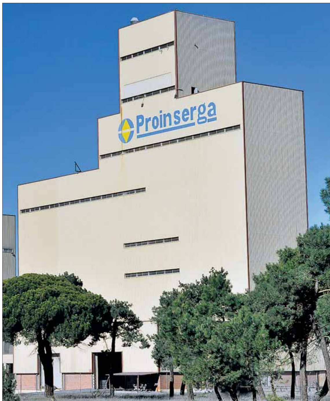
Imagen de una de las fábricas de pienso de Proinserga, situadas en Fuentepelayo. / KAMARERO
