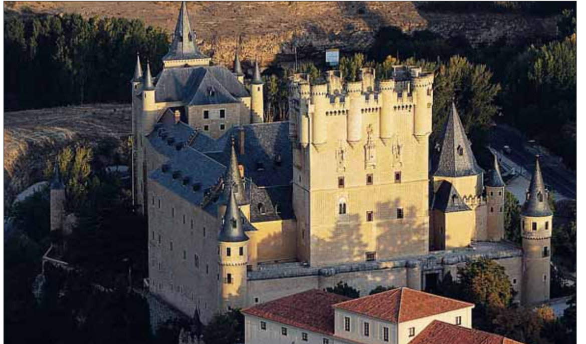
El Patronato del Alcázar está llevando a cabo un proyecto de restauración de las fachadas del costado sur. / JUAN MARTÍN
