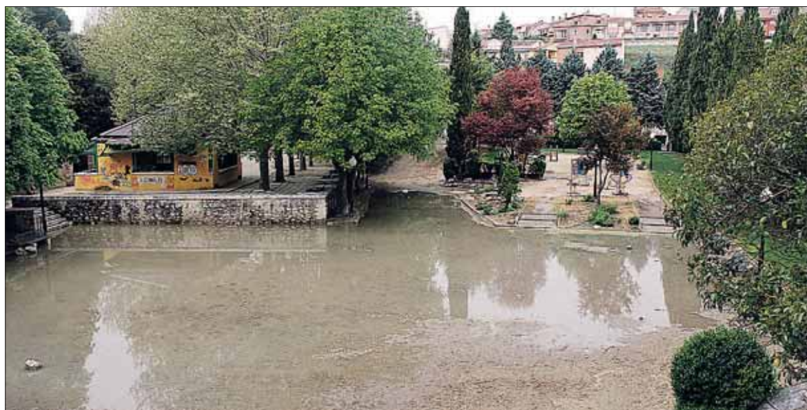
Los Paseos de San Francisco permanecían ayer parcialmente inundados a consecuencia de la tormenta. / CHANTAL NÚÑEZ
