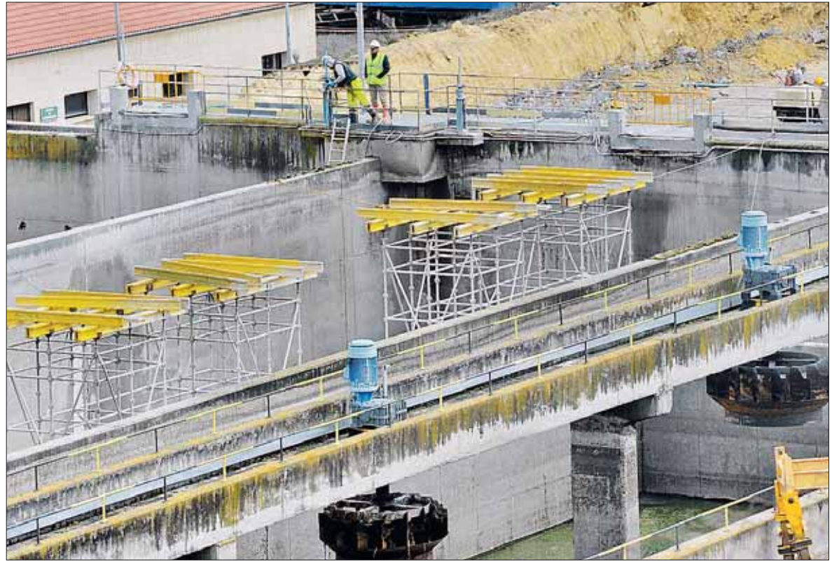
Imagen de operarios que trabajaban ayer en los depósitos de la EDAR de Segovia, situada en el valle de Tejadilla. / KAMARERO
