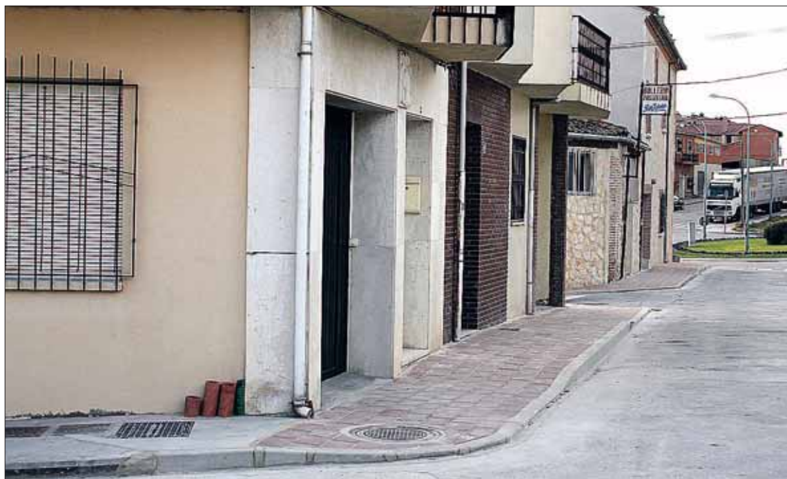
La calle Puerto Rico cuenta ahora con aceras de metro y medio y pasos de cebra visibles. / CHANTAL NÚÑEZ
