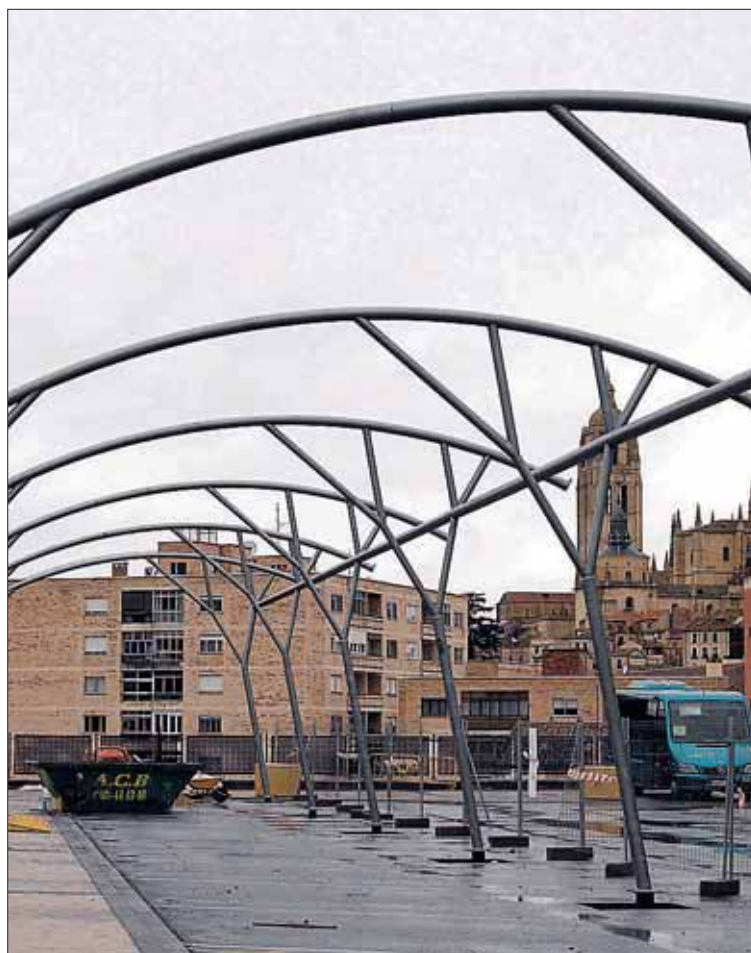
Obras de instalación de las dársenas de la estación de autobuses. / J. MARTÍN
