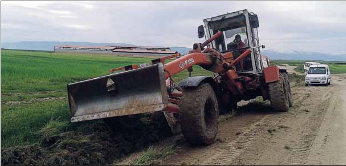
Una máquina de la Diputación acondiciona una cuneta en un vial de la provincia. / EL ADELANTADO
