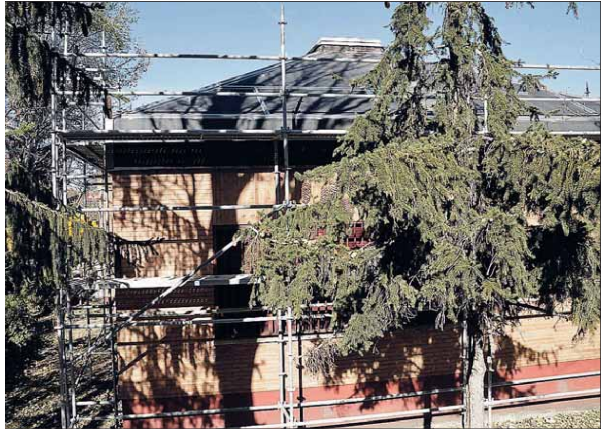
Los trabajos en la cubierta comenzaron el pasado mes de octubre y estaba previsto que concluyeran en enero. / JUAN MARTIN
