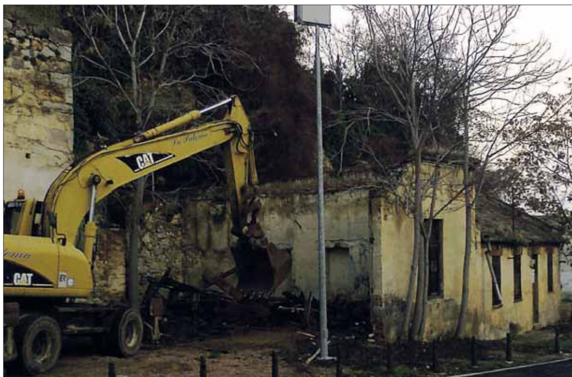
El derribo de la construcción, adosada a la muralla, al inicio del Paseo, se produjo con una máquina excavadora. / EL ADELANTADO
