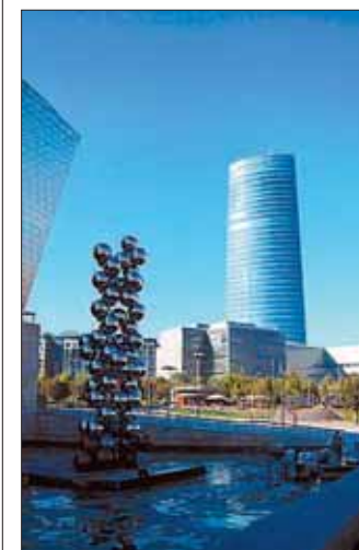
La sede de Iberdrola, en Bilbao.
