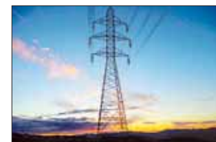
Una torre eléctrica.
