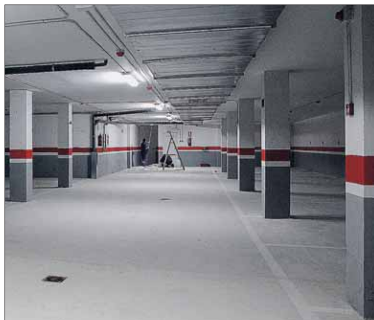
Interior del aparcamiento del área de Niñas Huérfanas./ GABRIEL GÓMEZ
