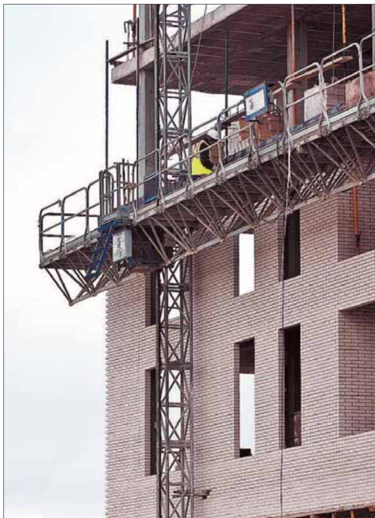
Un edificio en plena construcción. / LUIS LÓPEZ ARAICO
