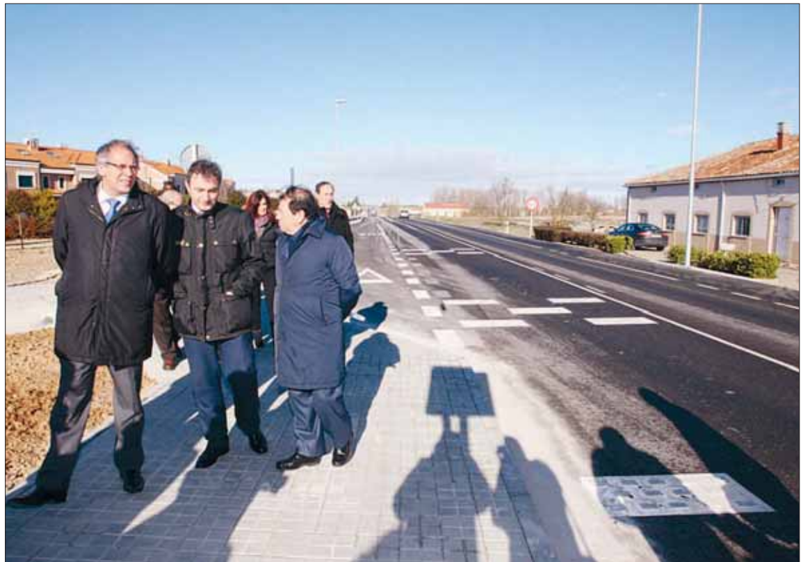
Jorge Urrecho (c) visitó el lunes las obras de acondicionamiento de la travesía de Villanubla (Valladolid) de la N-601. / ICAL
