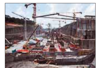
Obras del Canal de Panamá.
