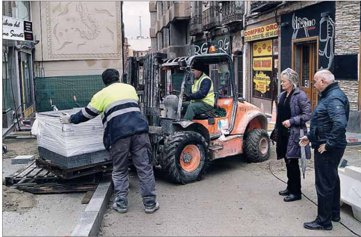
La concejala de Medio Ambiente y Protección Civil, Paloma Maroto, visitó las obras de reurbanización. / EL ADELANTADO
