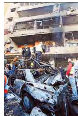
El coche destruyó un edificio.
