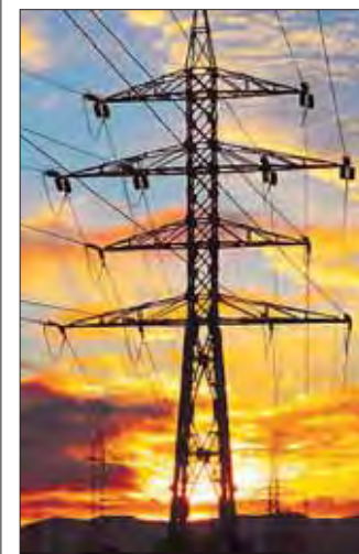
Una torre eléctrica.
