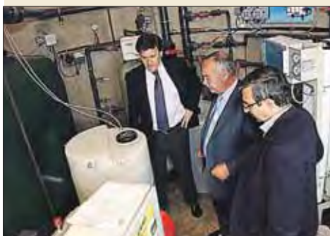
Sistema de potabilización de Codorniz. / E.A.
