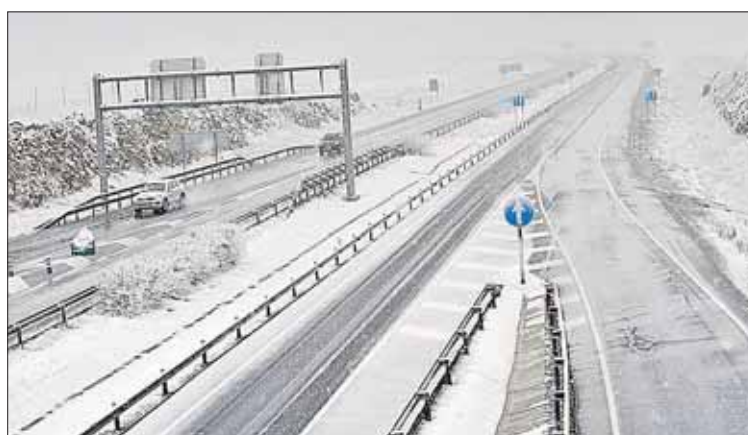
La circunvalación SG-20 acumuló unos centímetros de nieve. / KAMARERO
