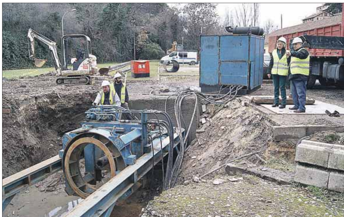
Imagen de la actuación que está llevando a cabo el área de Obras en la calle Puente de Sancti Spíritu. / EL ADELANTADO
