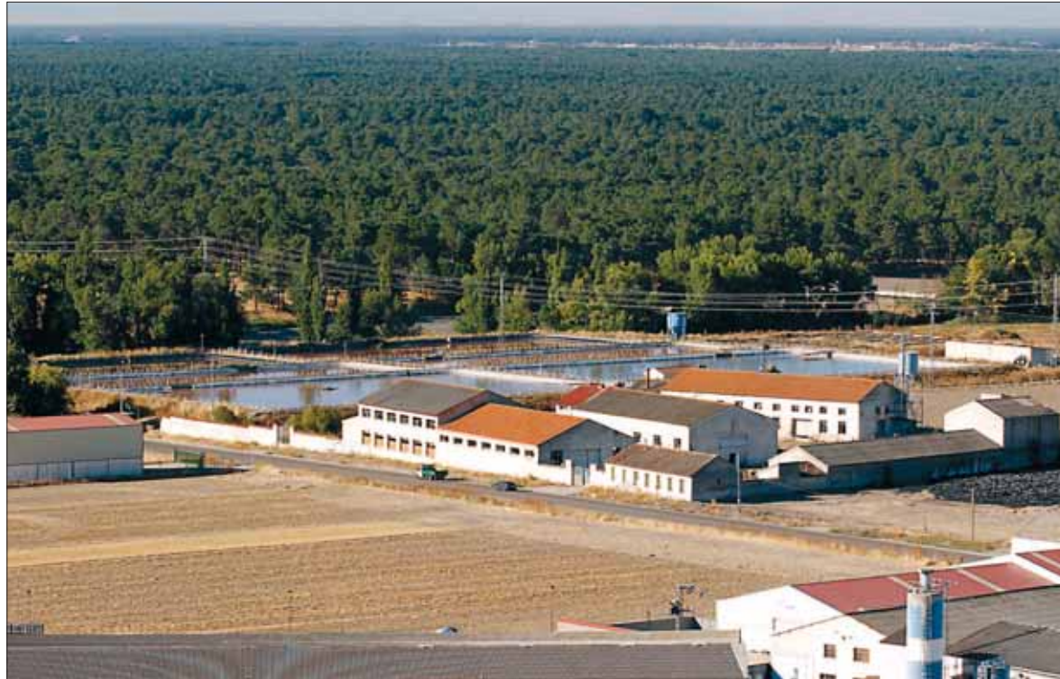
Estación Depuradora de Aguas Residuales (EDAR) del municipio./ GABRIEL GÓMEZ
