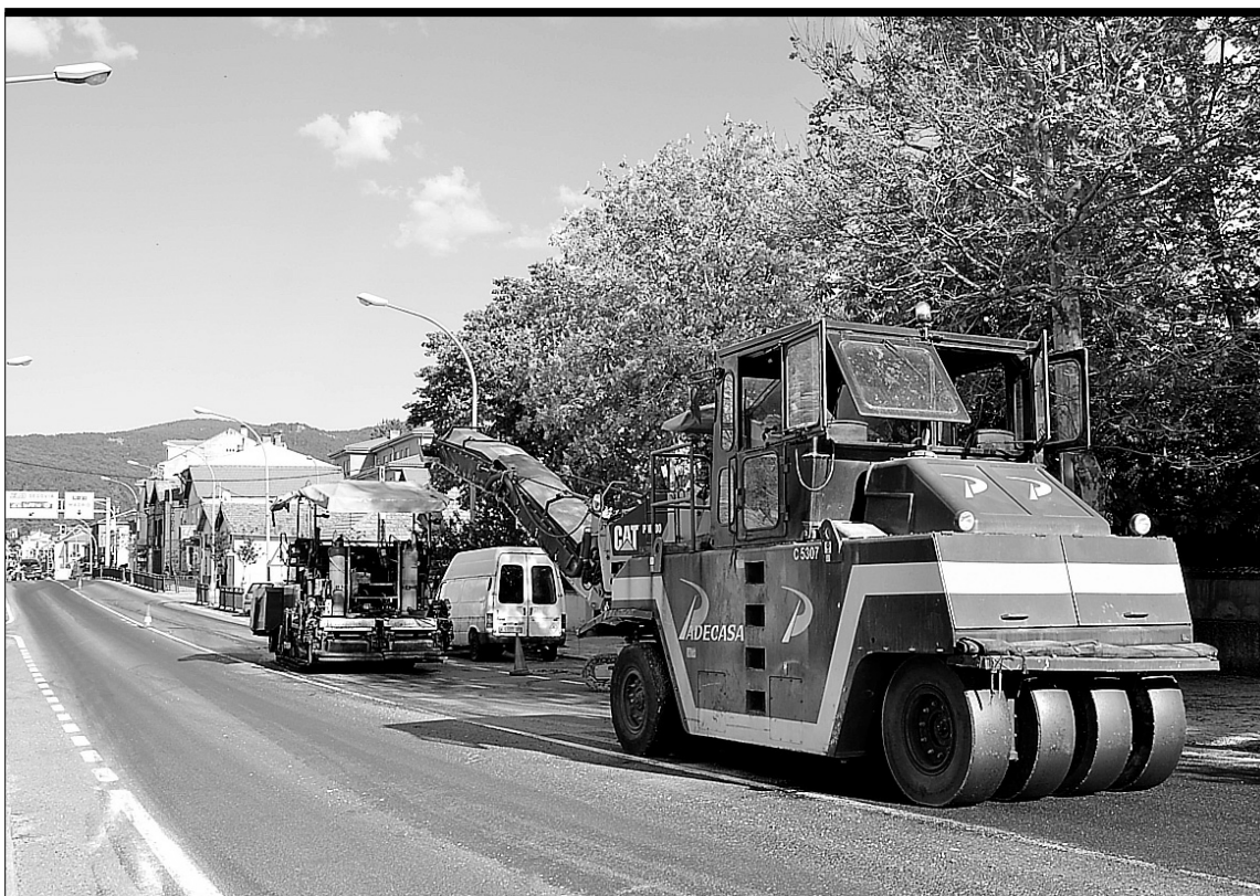
Concluye el asfaltado de la travesía de San Rafael. Ayer concluyeron las obras de asfaltado de la travesía de San Rafael, incluidas en la campaña de fresado y reposición de pavimentos deteriorados en la carretera N-VI (Madrid-A Coruña), ejecutadas por el Ministerio de Fomento. El desarrollo de las obras ha obligado a cortar el tráfico de forma puntual, en ambos márgenes de la travesía. / FOTO: PEDRO L. MERINO
