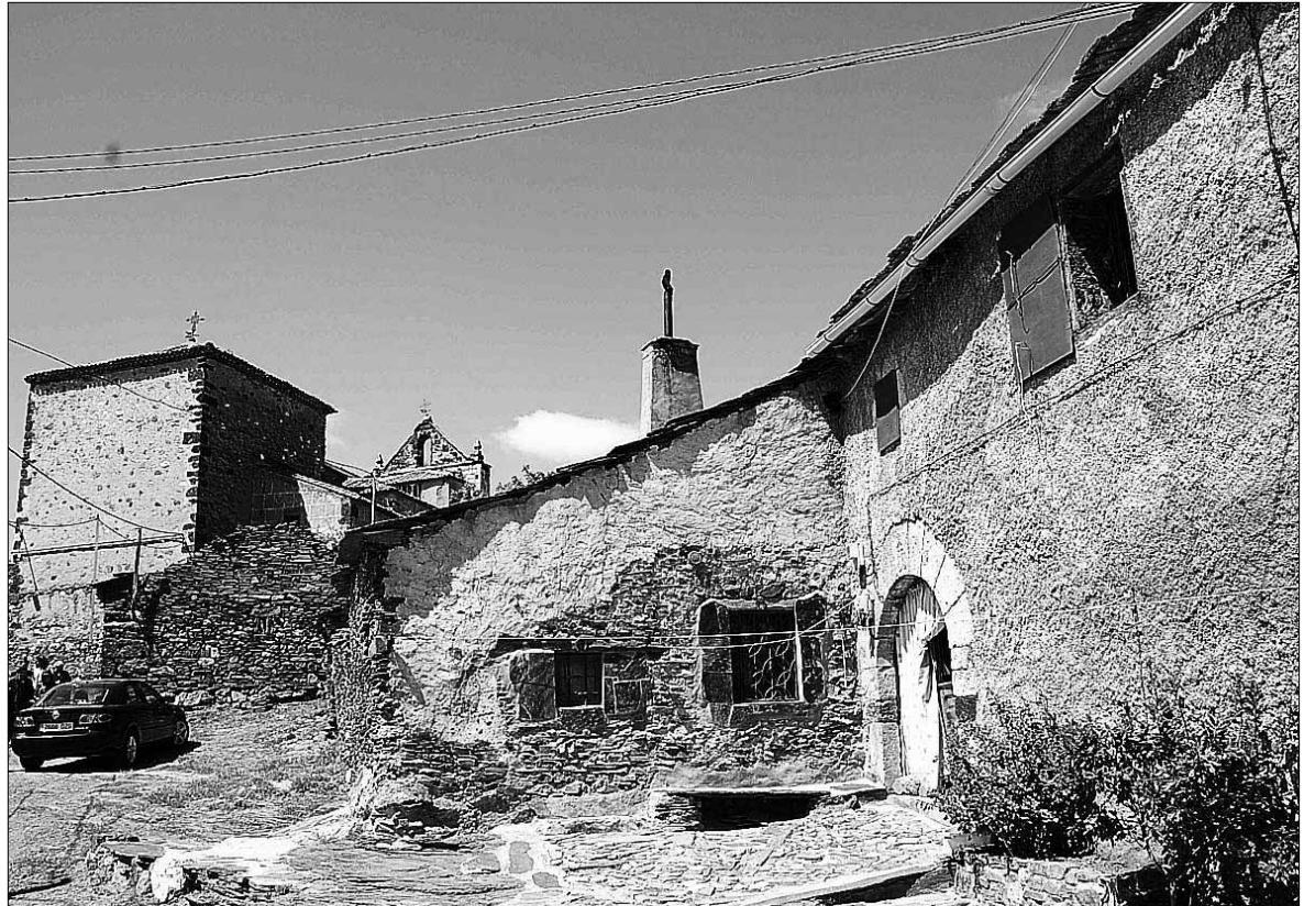
El Muyo es una de las poblaciones que se beneficiará de las actuaciones de rehabilitación del ARI. / JUAN MARTÍN
