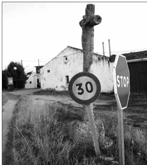
Cruz a la entrada de Escarabajosa, en estado lamentable. / JUAN CARLOS LLORENTE
