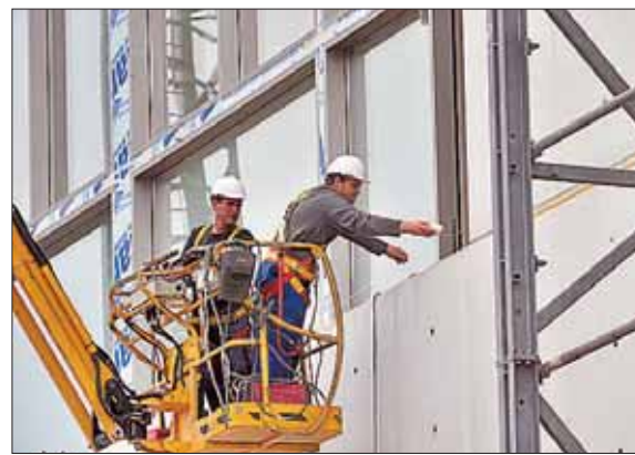
Dos operarios, trabajando en una de las fachadas. / KAMARERO
