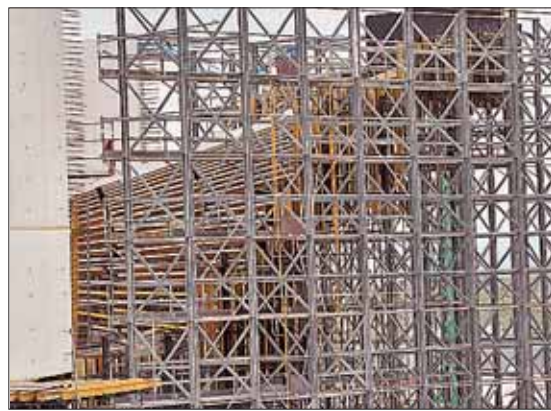
Andamios en la zona de la cúpula. / KAMARERO
