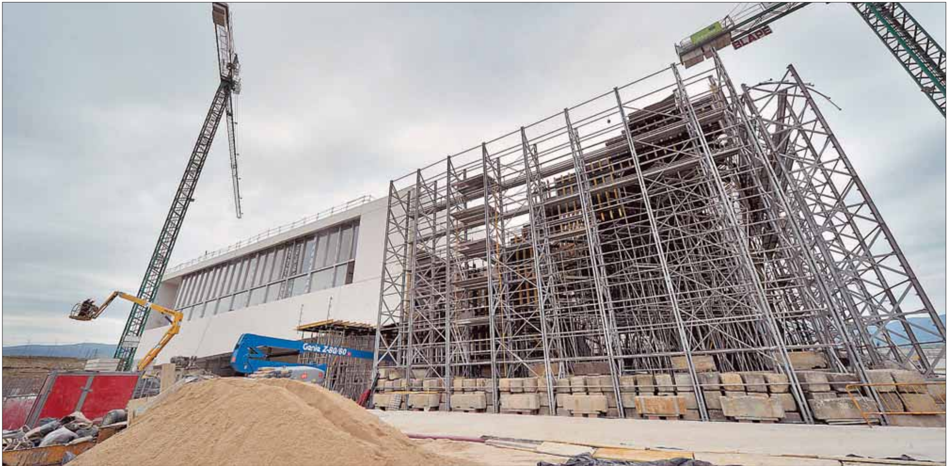
El edificio, de cuatro plantas, ha sido diseñado por Juan Carlos Sancho y Sol Madrdejós. La parte de los andamios corresponde a la zona que estará coronada por una cúpula en forma de bóveda. / KAMARERO
