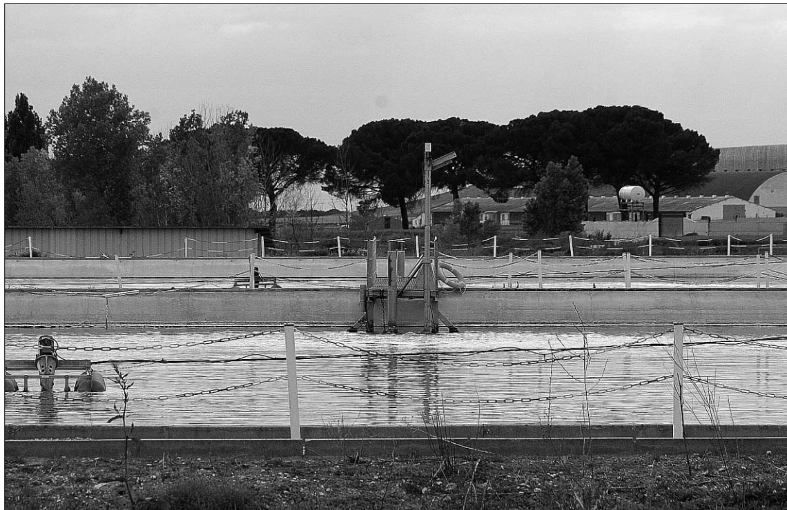
Instalaciones actuales de la estación depuradora de aguas residuales del municipio. / GABRIEL GÓMEZ
