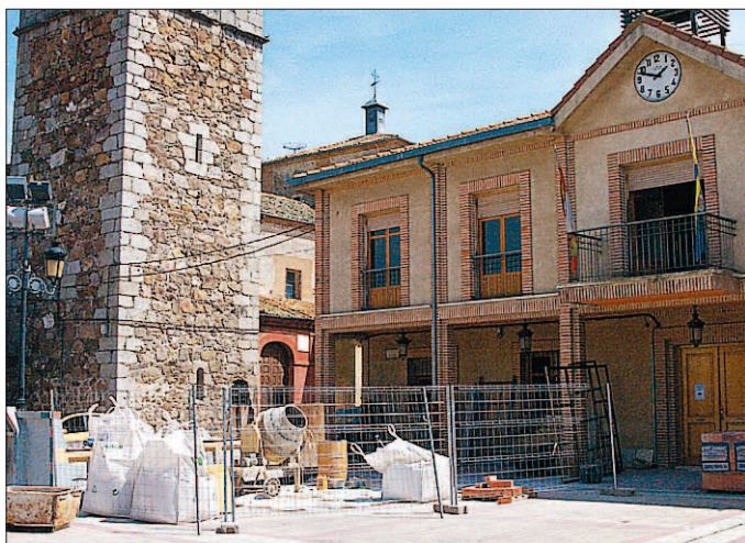
Obras en el Ayuntamiento de Navalmanzano. / GUILLERMO HERRERO
